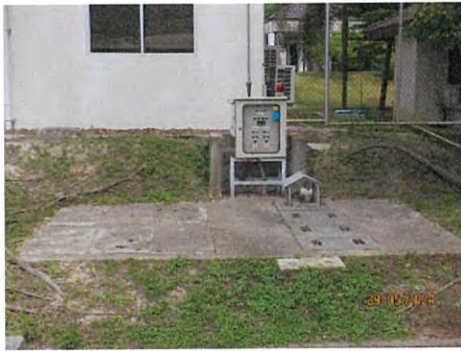
ภาพที่ 2.2-19 ถังพักน้ำเสียจากห้องน้ำ-ห้องส้วม
