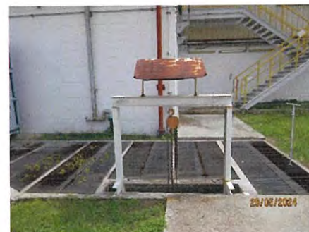
ภาพที่ 2.2-47 ประตูลำดับปิดกั้น กรณีเกิดเหตุฉุกเฉิน
