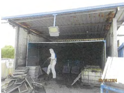
ภาพที่ 2.2-17 จุดชักล้าง โดยนำน้ำที่ผ่านการบำบัดแล้ว กลับมาใช้ล้างวัสดุ อุปกรณ์ต่างๆ
