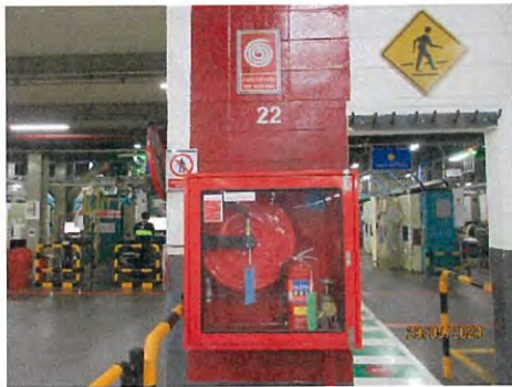
ภาพที่ 2.2-49 (ต่อ) อุปกรณ์ดับเพลิงภายในอาคาร
