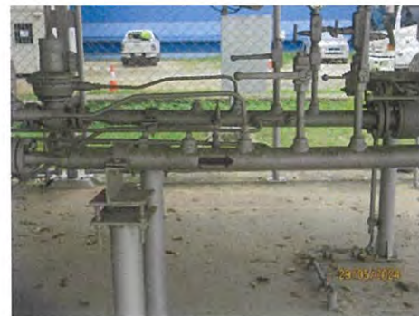
ภาพที่ 2.2-53 ข้อความแสดงทิศทางการหมุนวาล์วและข้อความแสดงทิศทางการไหลในท่อขนส่งก๊าซธรรมชาติ
